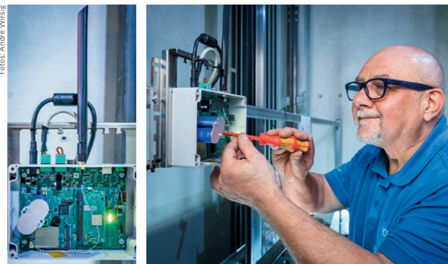
Auf dem Dach des Aufzugs montiert Mehmet Öztan, Aufzugstechniker von Vonovia, die Sensorik-Box. Bei der empfindlichen Technik muss er mit viel Fingerspitzengefühl vorgehen.
