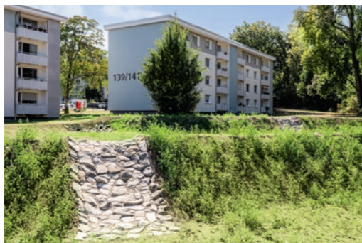
Die Versickerungsmulden sorgen für eine natürliche Entwässerung und tragen zu einem guten Mikroklima bei.
