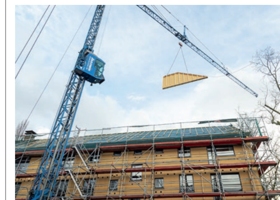
Die Fassadenelemente, die mit einer nachhaltigen Dämmung ausgefüllt werden, bestehen aus Holz.
