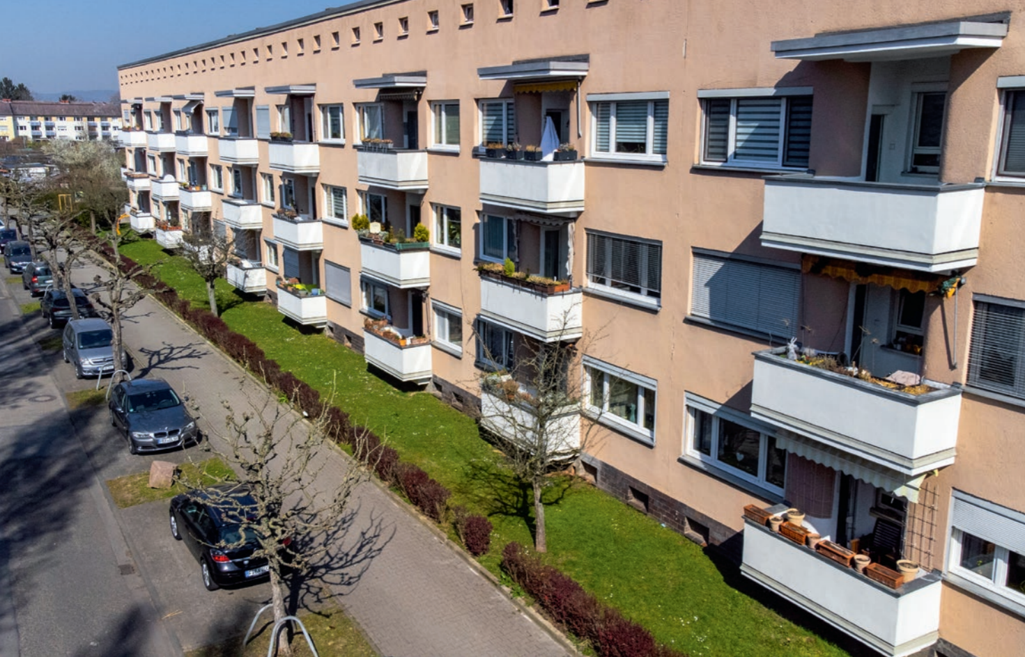
Der Anspruch des Frankfurter Wohnungs- und Städtebauprogramms in den 1920ern war es, praktisch zu bauen, nicht dekorativ. So wie hier in der Straße Nußzeil.
